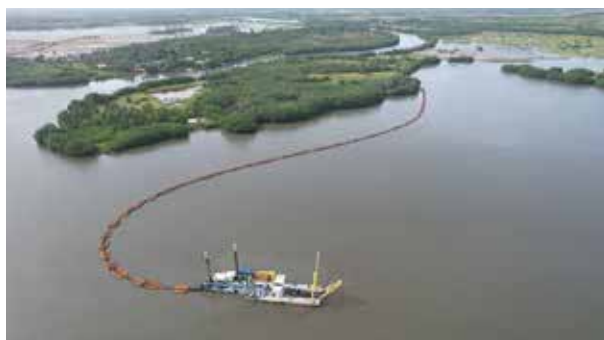
Vue aérienne de la drague avec ses pipelines de refoulement
