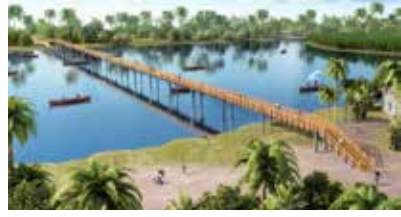
Maquette de la passerelle et Image de la passerelle de Mèko en cours de construction
